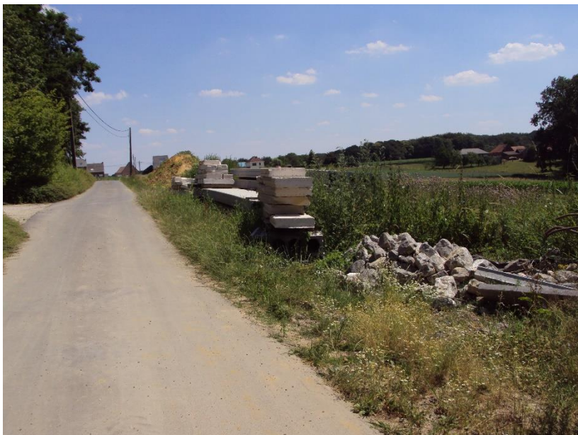
FIGUUR 30: BOUWMATERIAAL IN DE BERM (BOSSTRAAT)
