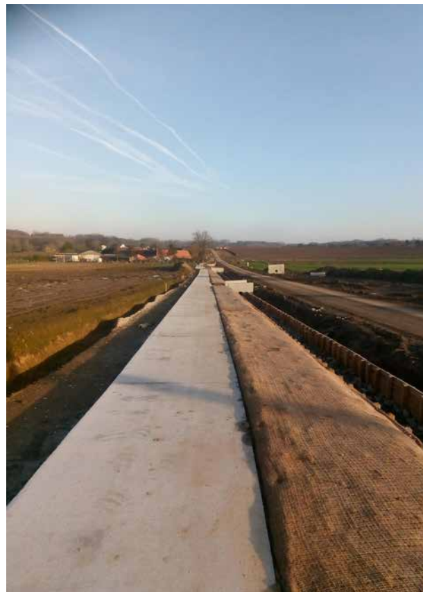
Het fietspad tussen de Hasselstraat en Schorisse krijgt stilaan vorm.
